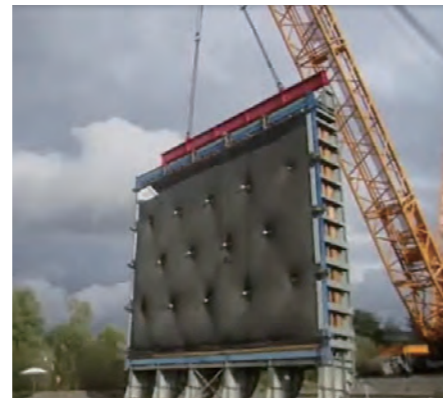
総重量約300t、幅12.5m×長さ10.0m×厚さ1.2m、補強材間隔2.5m千鳥配置
