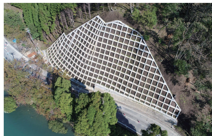
葛籠尾崎大浦線補助道路修繕工事
