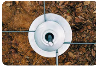
UN支圧板(上部)設置
