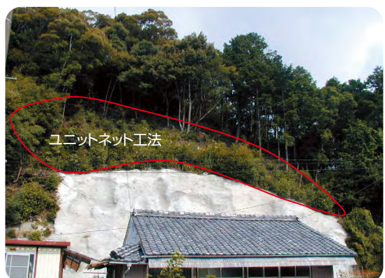
吹付け工との併用
