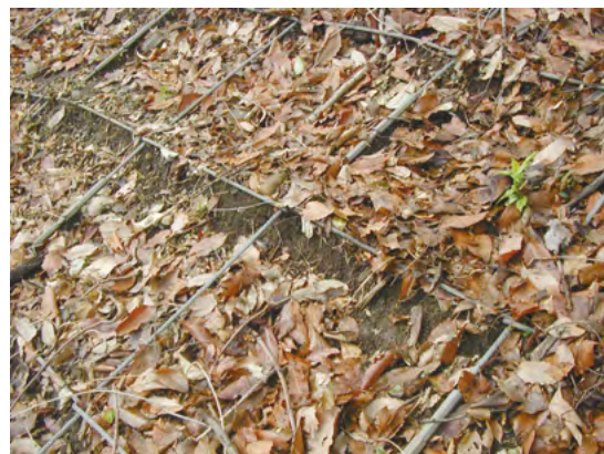
ネットに土砂や落葉が堆積している
