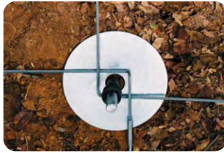
UN支圧板(下部)設置
