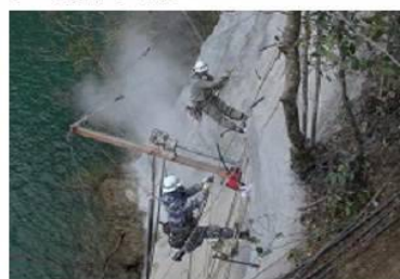
ケーブルカー架線上での施工
