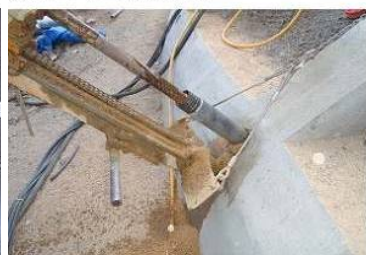
削孔工（二重管穿孔）
